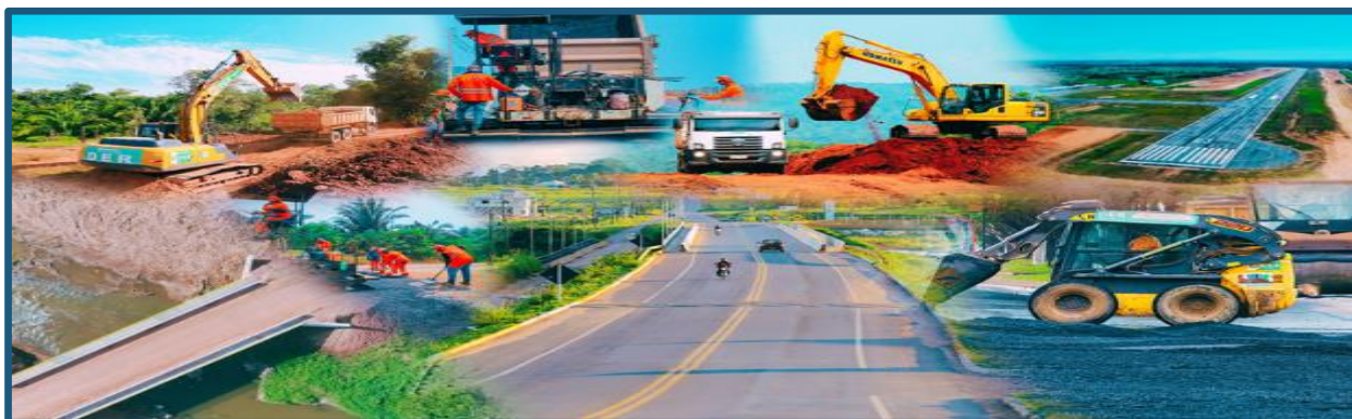
Imagem 10: Obras de Infraestrutura DER
