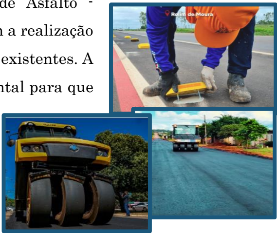
Imagem 13: Obras na Rodovia
